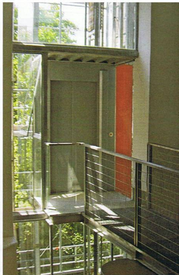
Der im Innenhof angebaute Liftturm hat seinen obersten Ausstieg im Wintergarten, der wiederum auf die Dachterrasse führt – alles barrierefrei.
