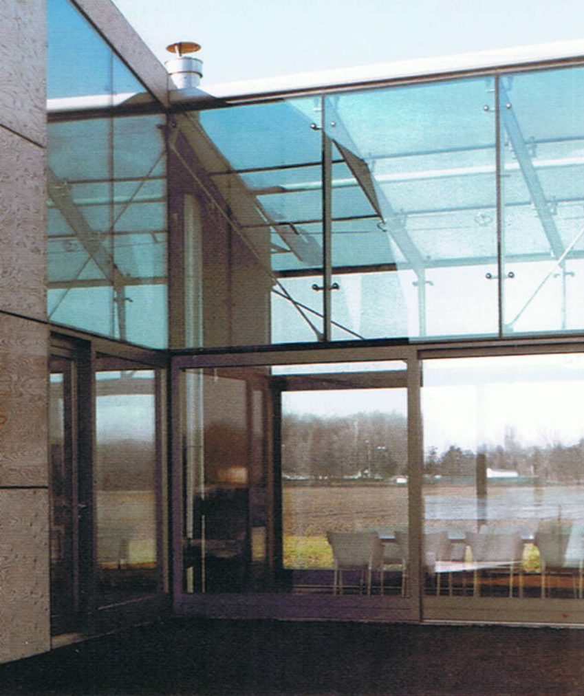
Durch den Wintergarten wird eine Verbindung zum See geschaffen.
